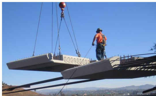
Izvođenje rešenjem prednapregnutih traka („stress ribbon“)
